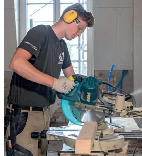
↖ **Segare e tagliare** Per tagliare e adattare singoli componenti, i carpentieri e le carpentiere utilizzano diversi utensili, ad esempio fresa e seghe.
