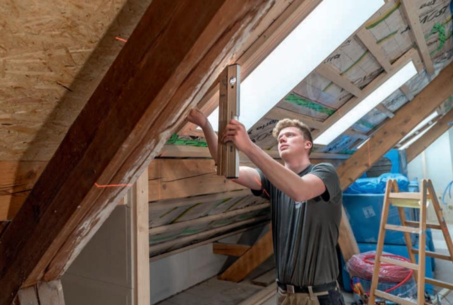
Con il piombo laser e la livella a bolla d'aria, Sven determina la posizione dei montanti che dividono una parete.
