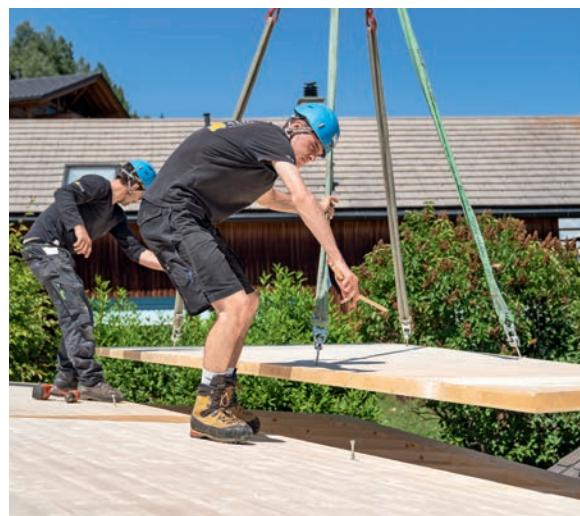
↖ **Montaggio sul cantiere** Travi, tavole e altri elementi prefabbricati in officina vengono adattati alla costruzione e montati.
